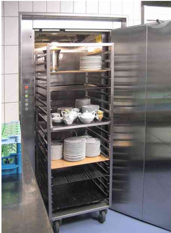
Kabine und Drehtüren sind aus Chromstahlblech gefertigt und 1.80 m hoch.
