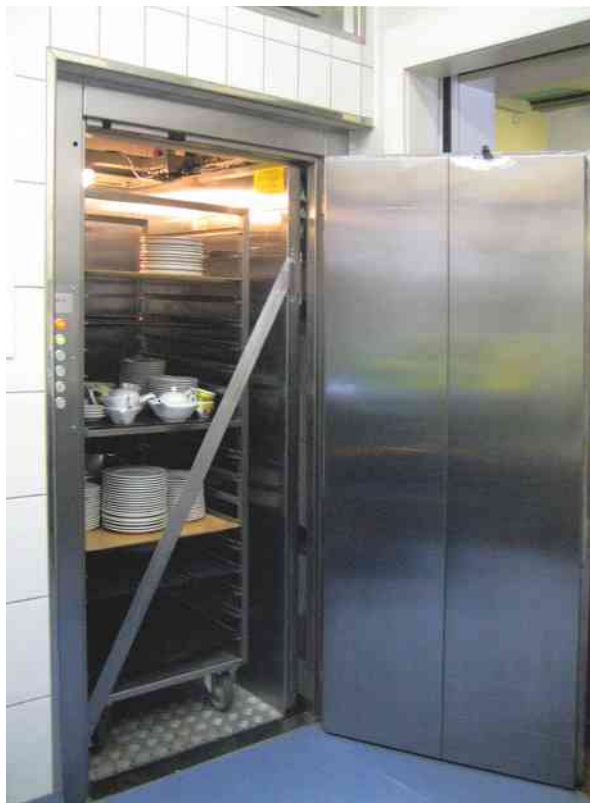
Kabine mit Diagonalschranke verhindert das Verklemmen der Gastro Norm Wagen während der Fahrt.
